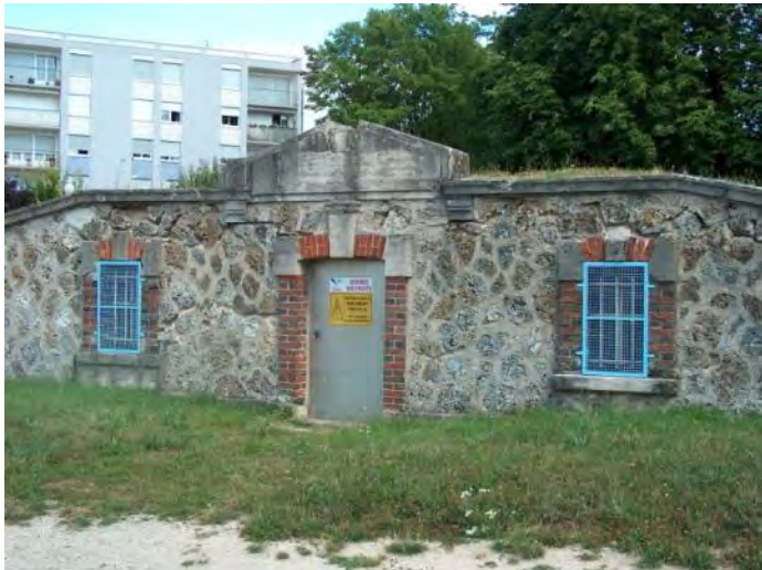
Réservoir des Pavements
