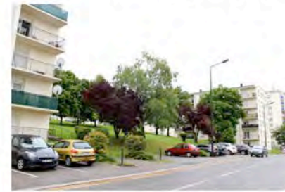
espaces semi-collectifs en pied d'immeubles
