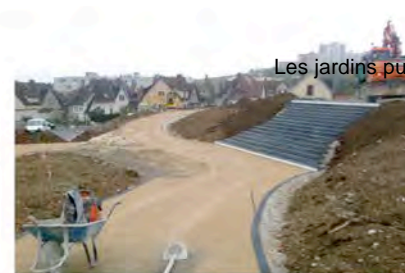
travaux square Pol Roger
