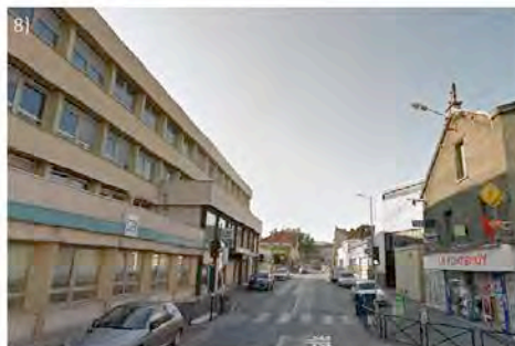
8) bâti vieillissant assez hétérogène
