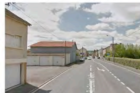
bâti de qualité hétérogène, façades non continues
