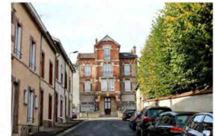
arbres dépassant des murs
