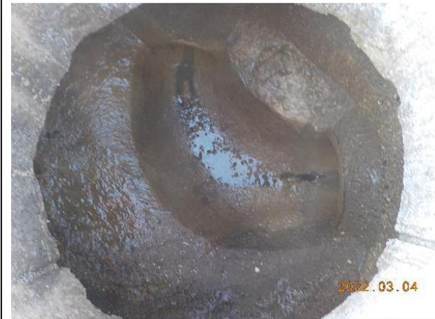
Légère corrosion du béton
