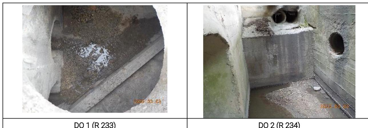
Le DO 2 est positionné à l'aval du tronçon unitaire de la rue des Chetillons et du tronçon pluvial de la rue de la Gare. Le débit conservé rejoint le réseau unitaire vers le DO1, le trop-plein rejoint le fossé.
