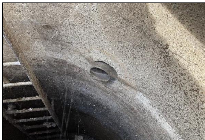
Figure 35 : Vue sur le trop-plein du PR Gare vers le milieu naturel
