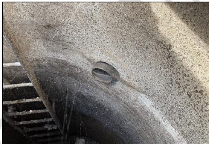
Figure 46 : Vue sur le trop-plein du PR Gare vers le milieu naturel
