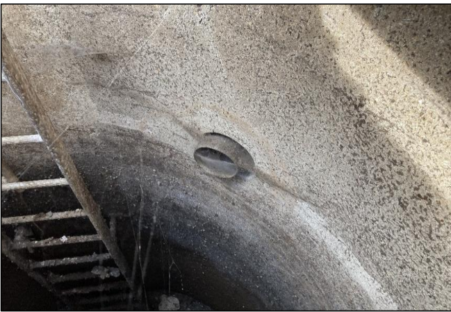
Vue sur le trop-plein
