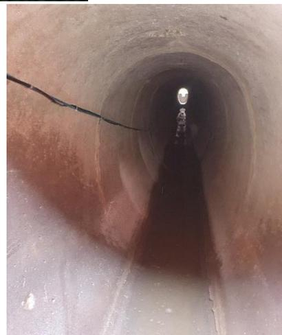
**Objectif de la mesure :** Mesure du débit sur le collecteur pluvial en aval du DO entrée STEP
