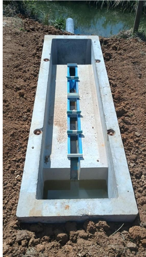
Lagune de Villers-aux-Bois – Canal de sortie
