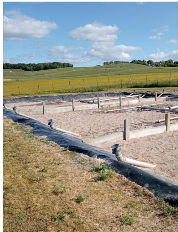
Step de Loisy – Réfection des casiers filtrants
