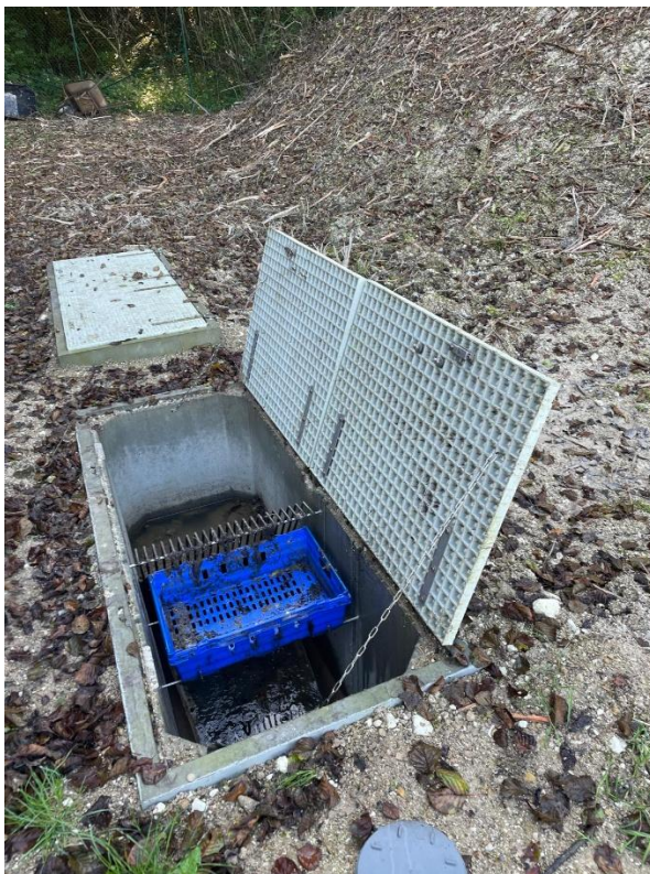
Lagune de Moslins – Renouvellement des prétraitements
