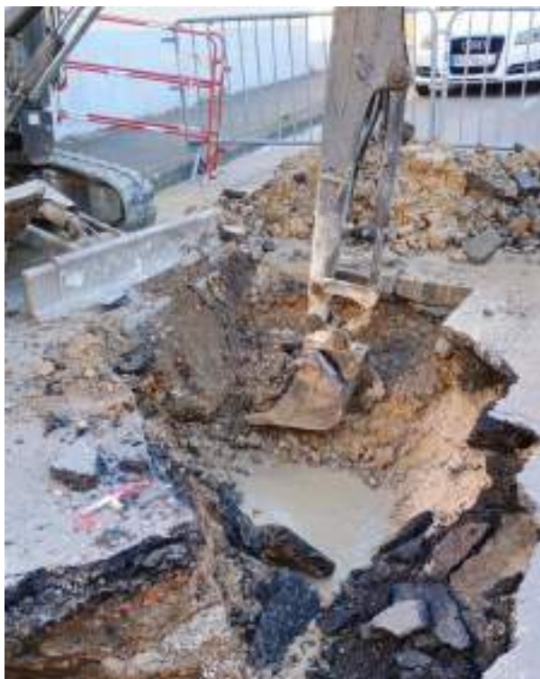
Réparation casse conduite
